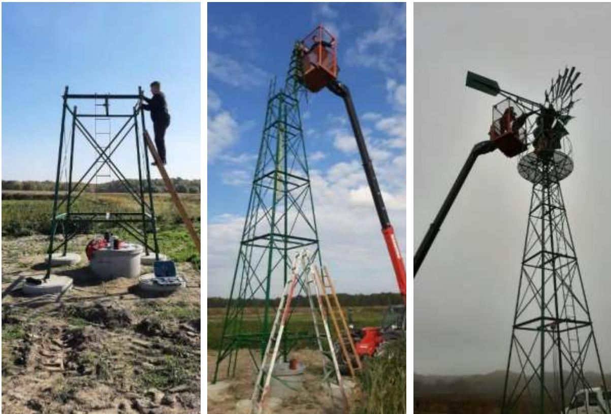
Abbildung 23: Der Aufbau des Windrads.
