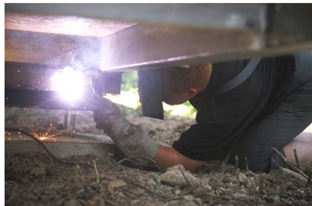
Abbildung 7: ....und auf dem genau horizontierten Drehkranz festgeschweißt.
