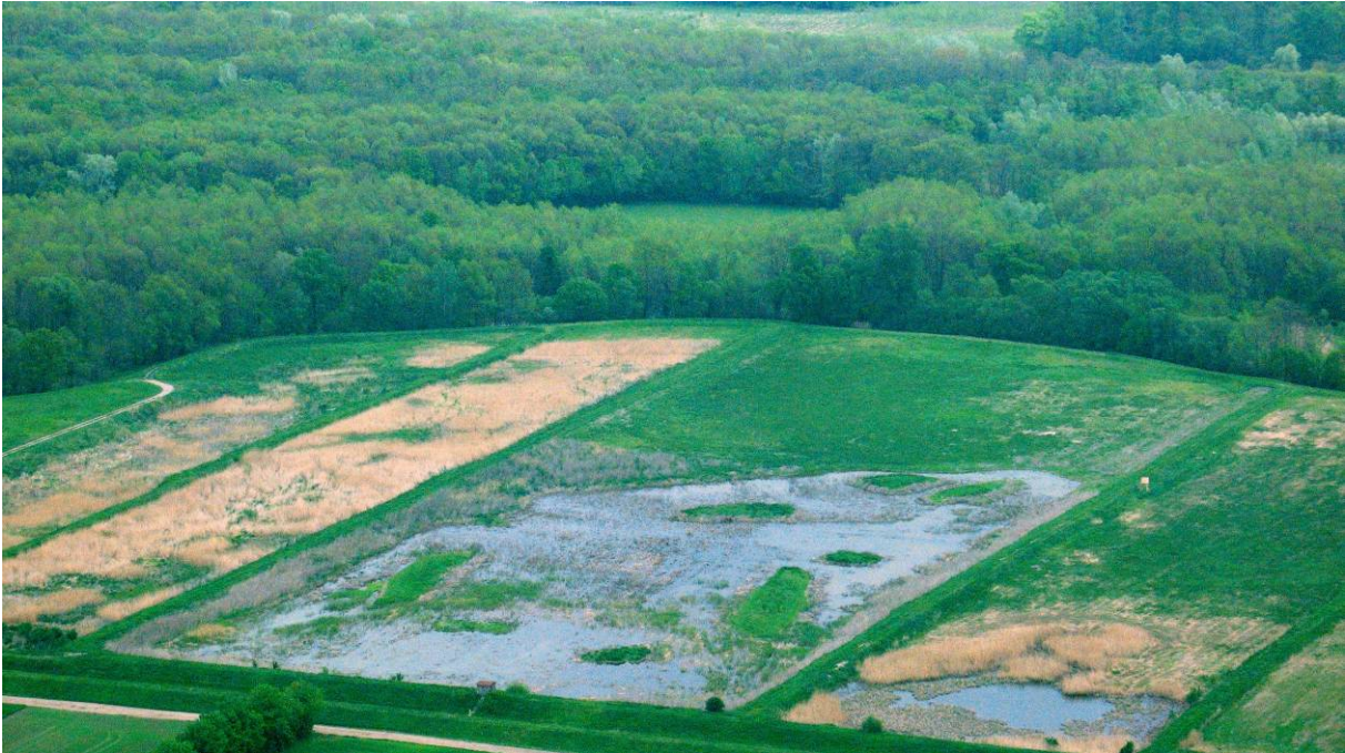
Blick auf die Anlandebecken mit den frisch gefluteten Becken 3 und 4 und den gerodeten Inseln in der 3,5 ha großen Wasserfläche; links im Bild die Altschilfbestände der Becken 1 und 2 ohne Eingriffe (30.4.2008, Foto: R. Riegler).
